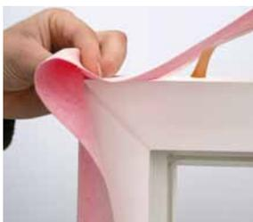
通常来说，湿度大的空气会从温度高的一端向温度低的一端传输，若在窗口安装时窗框与砖石结构之间的接缝不严密，这将会导致宝贵的能源产生
